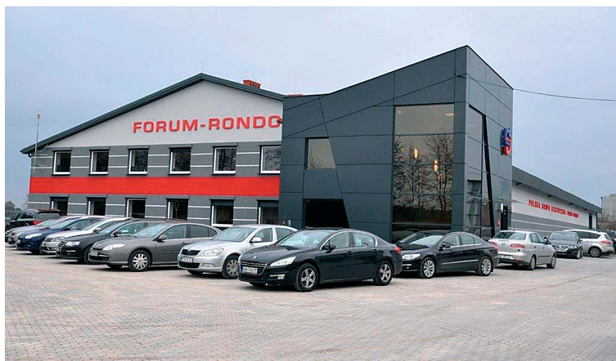
W nowej siedzibie przedsiębiorstwa, kosztem ponad 2,5 miliona złotych zbudowano nowy budynek biurowy, zmodernizowano magazyn, utwardzono teren, wstawiono nowe regały magazynowe
